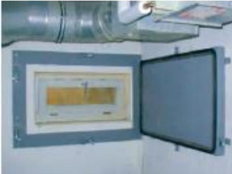
Abbildung 6, Druckdichtes, selbstschließendes Fenster
